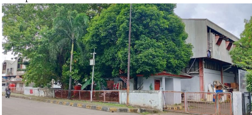
Gambar 43. Sewa Gedung Gudang BMN Sumber: Tim Perlengkapan Biro Umum
