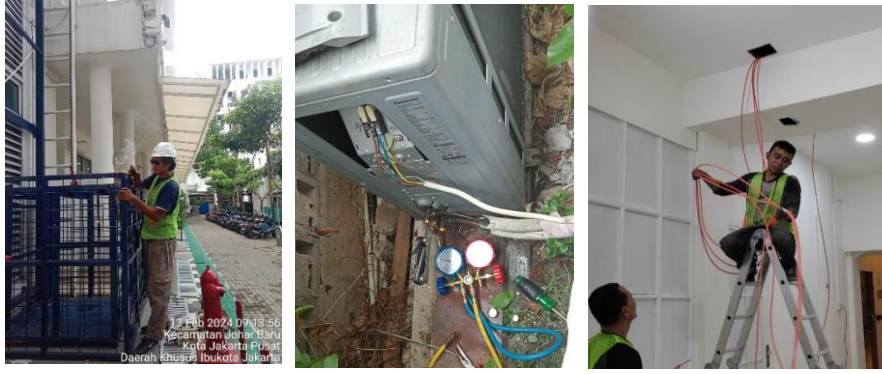
Gambar 30. Kegiatan Perawatan Gedung dan Bangunan (2)
